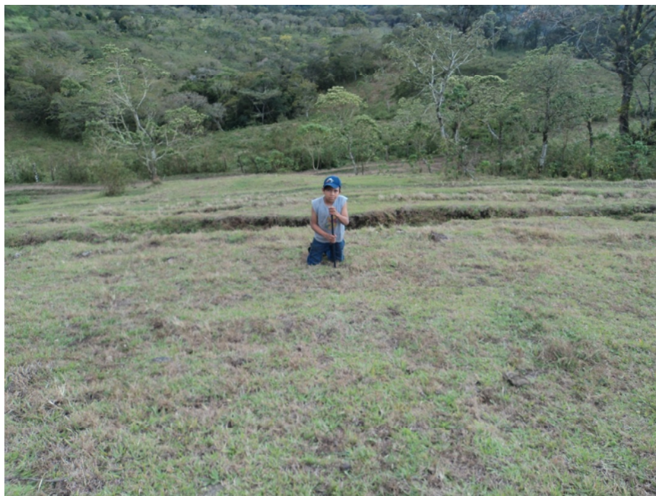
Area de Deslizamiento
