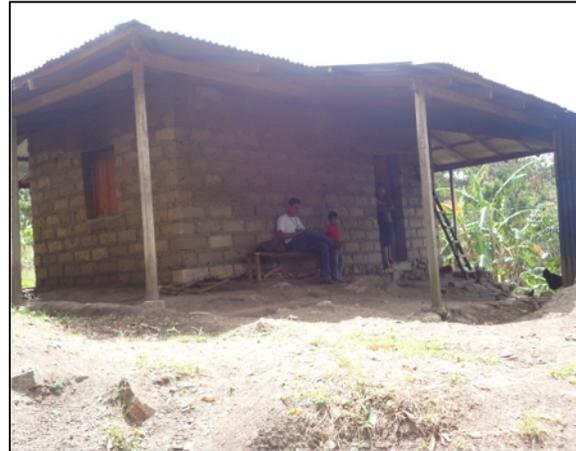
A simple vista, las viviendas no están construidas para soportar inundaciones, vientos huracanados, tampoco sismos mínimos, ni deslaves, y no llenan las mínimas normas técnicas de construcción. Algunas están construidas de adobe, tablones, y otras más fuertes y recientes, construidas de bloque con madera y techo de zinc y teja. Muchas viviendas tienen una estructura en malas condiciones.
