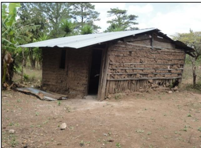
En cuanto a las viviendas, el problema radica en el tipo de material de construcción que se ha utilizado, son de diseño básico con piso de tierra, con techos de zinc y teja con vigas de madera predominando el adobe con repello, solamente la Casa Comunal está construida de talquezal o embarrado y dos casas hechas de madera. Las casas presentan solamente un cuarto o dormitorio en su mayoría.
