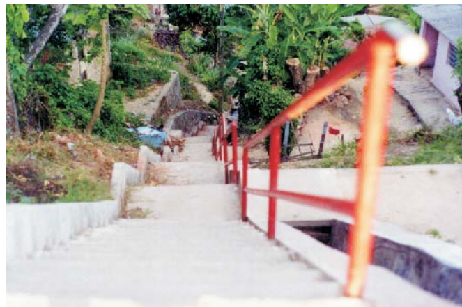
ESCADARIA COM CORRIMÃO LATERAL Córrego do Tiro, Recife
