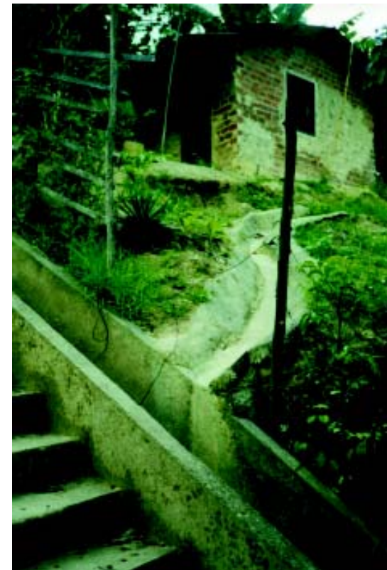
CANALETA PRINCIPAL ACOPLADA À ESCADARIA RECEBENDO CONTRIBUIÇÃO DE CANALETA DE BORDA
