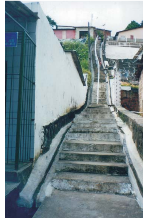
ESCADARIA COM CORRIMÃO CENTRAL Córrego do Tiro, Recife
