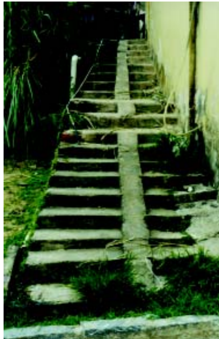
RAMPA IMPROVISADA entre os DEGRAUS
