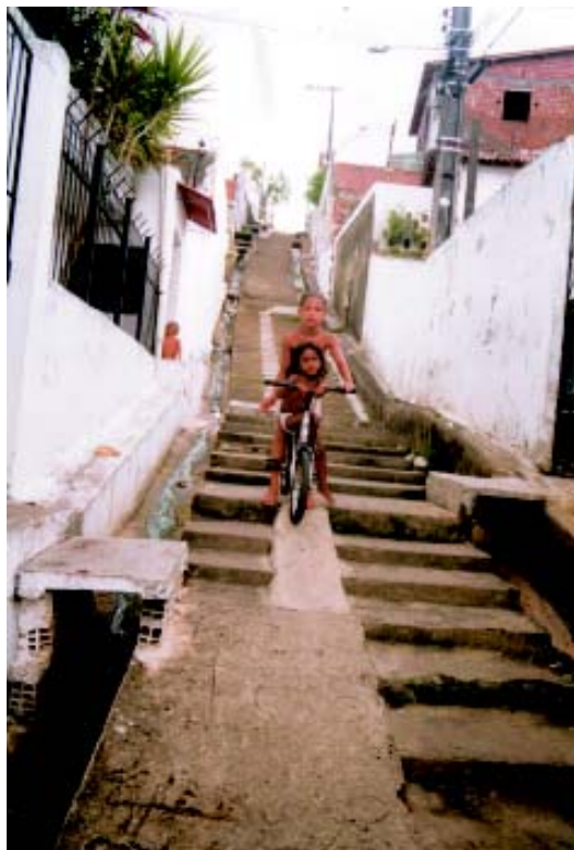
RAMPA ADAPTADA À ESCADARIA para ACESSO de CARRINHO de MÃO e de FEIRA, BICICLETA e MOTO Vasco da Gama, Recife
