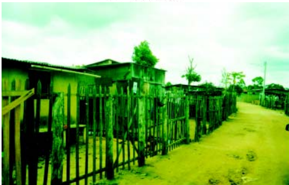
PRECARIEDADE das MORADIAS de INVASÃO nas ENCOSTAS Frei Damião, Abreu e Lima
