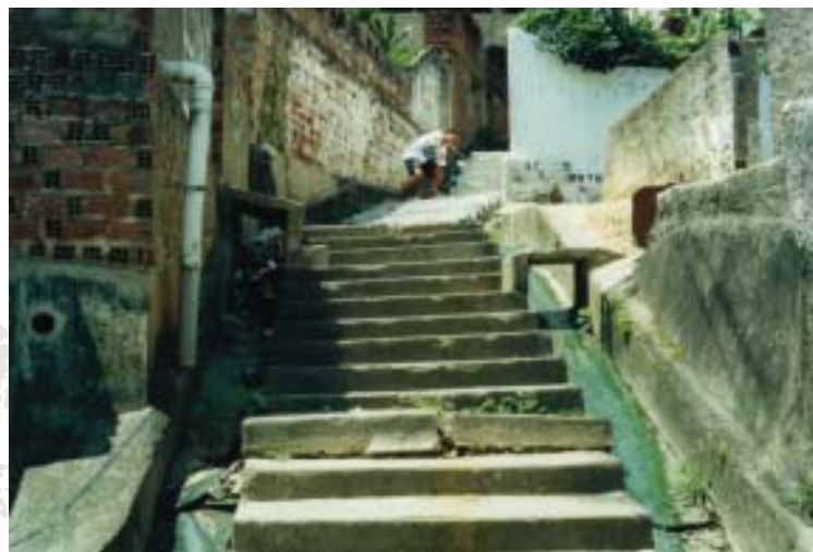
CANALETA LATERAL de ALTA VAZÃO Morro da Conceição, Recife
