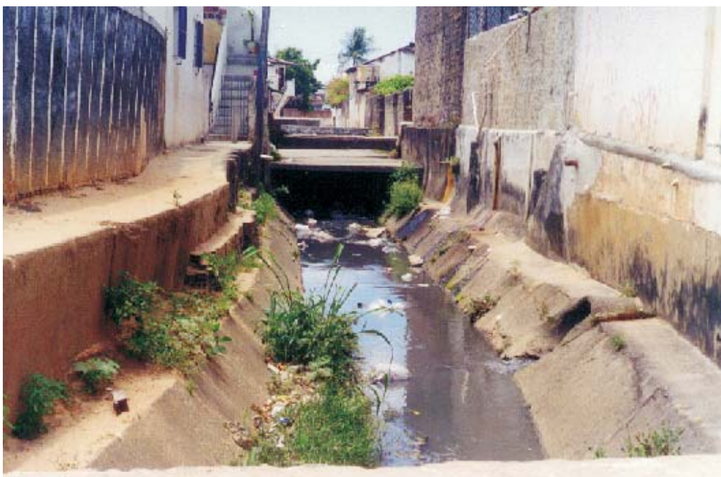
CANAL SISTEMA de MACRODRENAGEM Vasco da Gama, Recife
