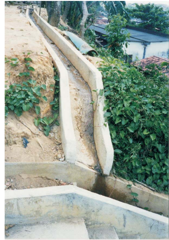
CANALETA de BORDA ACOPLADA à CANALETA PRINCIPAL
