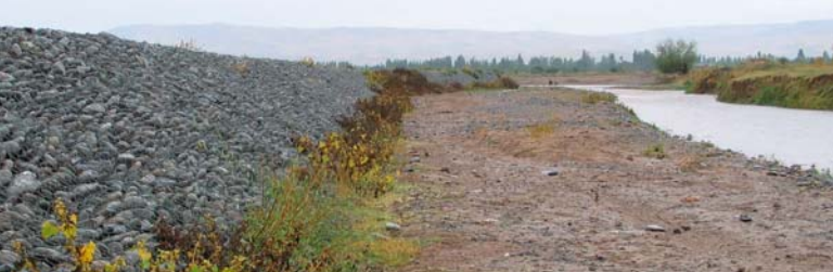
Renforcement des berges du fleuve.
