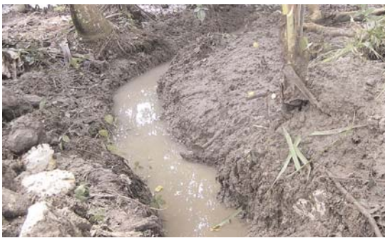
À Radefasu, dans la province de Malaita, les volontaires des deux communautés travaillent ensemble (photo du haut) à l'aménagement d'un canal de drainage (photo ci-dessus).
