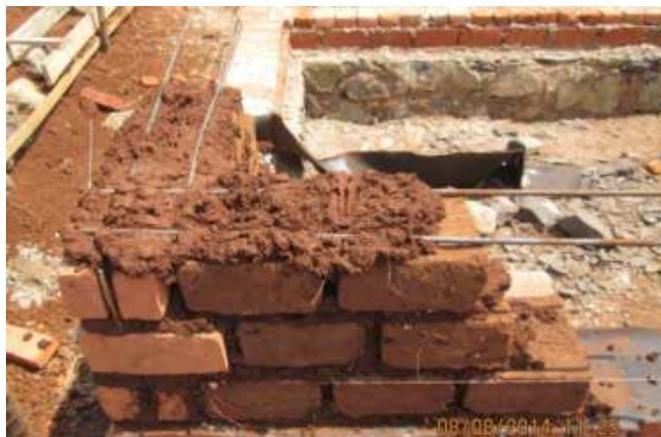
Des fers à béton de diamètre 8 et de 1m de long sont insérés toutes les 3 ou 4 rangées d'adobe dans une maison modèle construite dans le cadre du programme PROECCO, au Rwanda. Ces maisons ont très bien résisté à un séisme de magnitude 5,6 ayant provoqué des dégâts sur les bâtiments limitrophes, à l'automne 2016<sup>76</sup>. Photo extraite de *Implementing a building with adobe* : Logbook, PROECCO program, SKAT, CRAterre et Amicor, 2015, <https://craterre.hypotheses.org/3105>
