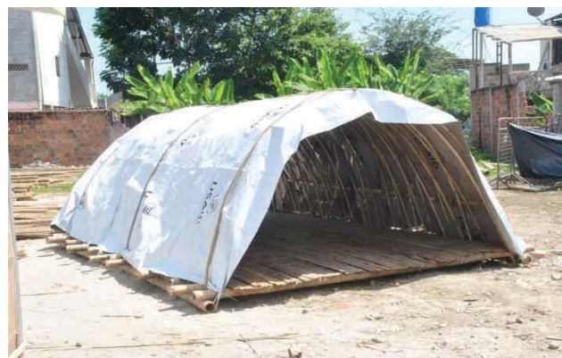
Refugio de emergencia terminado
