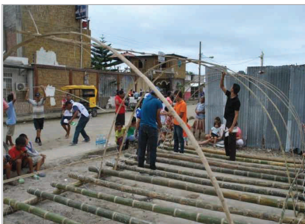
Construcción de tarima
