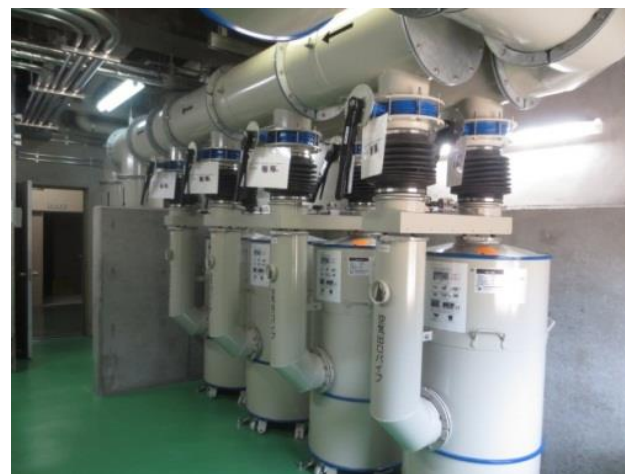
放射線防護施設内のフィルタリングシステム
