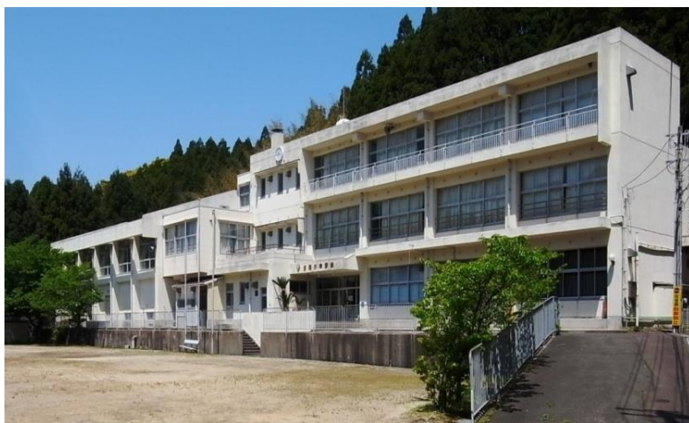
放射線防護施設(高浜町 旧音海小中学校)
