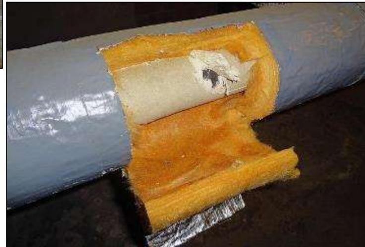
**Papel de isolamento ou barreiras de vapor com asbestosos podem ser encontrados dentro de outro tipo de isolamento sem asbestosos.**
