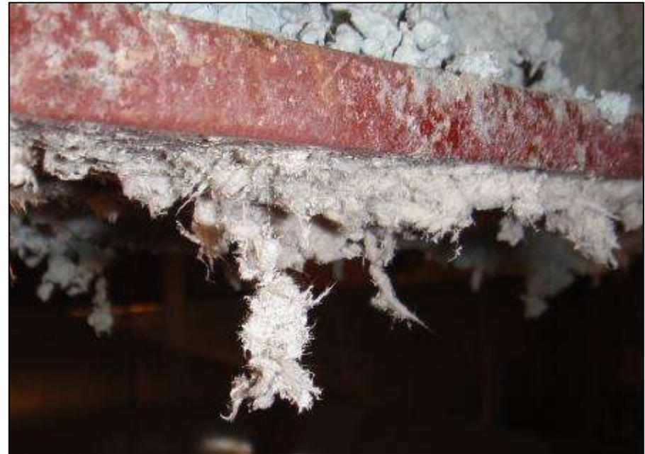
**Condições precárias de asbestos pulverizado aplicado na proteção de estruturas metálicas contra incêndio.**
