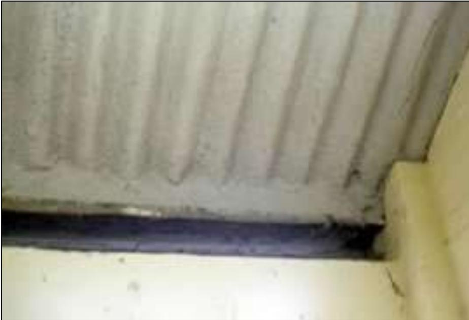
**Asbestos pulverizado na parte de baixo de um tecto de cimento, para isolamento térmico.**
