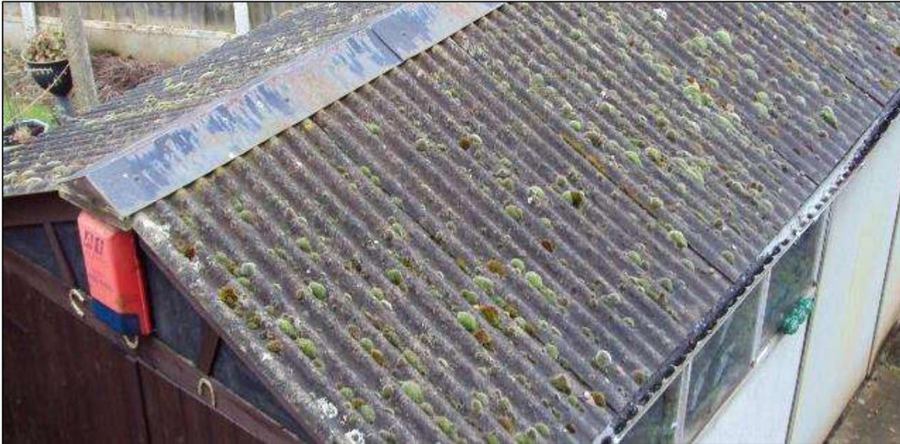
**Placas de asbesto-cimento em telhados, paredes podem necessitar ser removidas se estão danificadas.**
