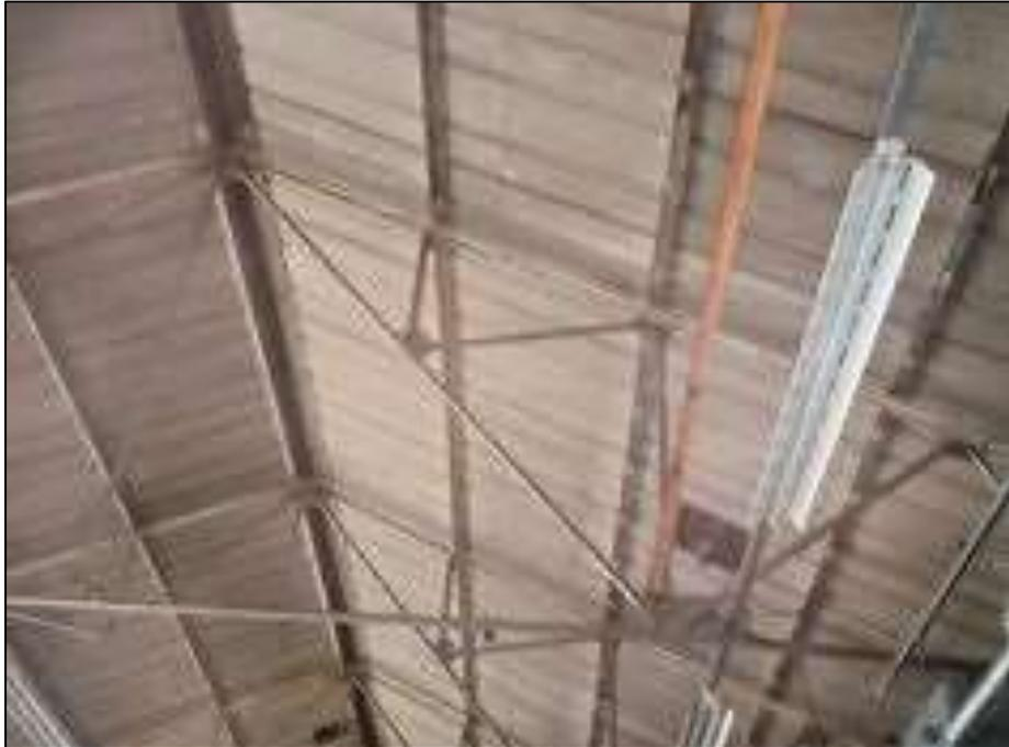
**Revestimento inferior de tecto de cimento com uma camada de isolamento de estrutura similar a contraplacado com asbestos.**
