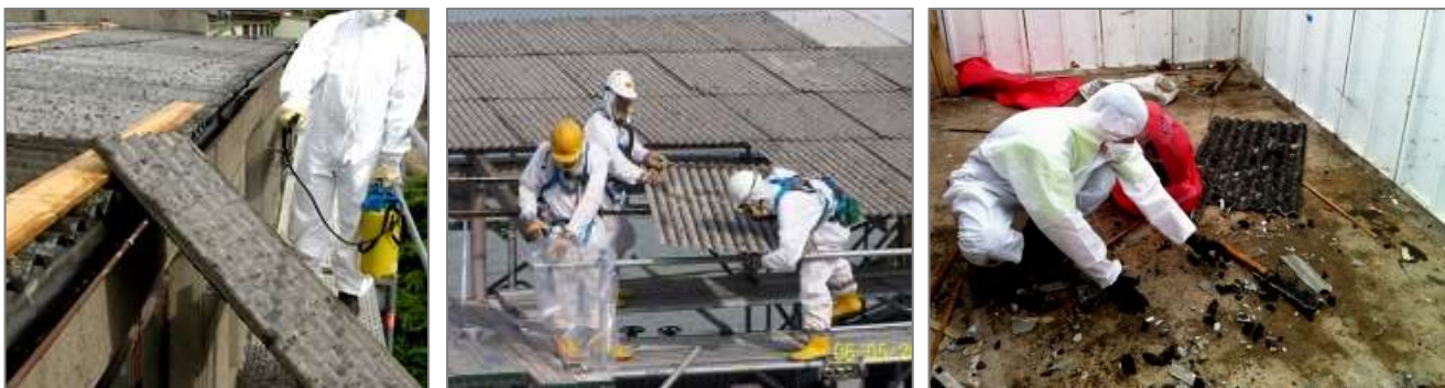
Figura 7 – Remoção de escombros e telhados de fibrocimento contendo amianto,
