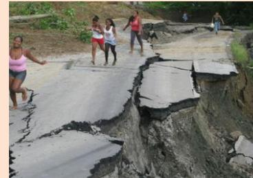
Destrucción de parte de la carretera Achote-Esmeraldas-Quinindé por deslizamiento del talud de soporte de la vía.
