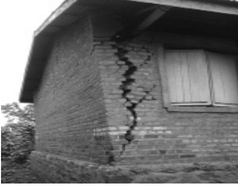
الرسم ٨: تشققات تسببتها هزة أرضية في مدرسة في روندا
