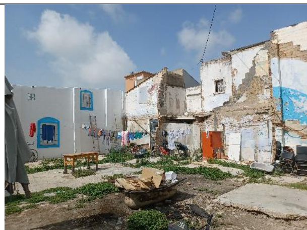
Figura 15: Edificaciones del lado oeste en asentamiento Pedros 1
