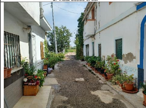
Figura 16: Edificaciones y urbanización asentamiento Pedros 1. Vista hacia el norte
