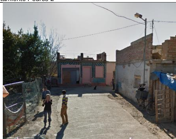
Figura 22: Edificaciones del lado oeste en asentamiento Pedros 2
