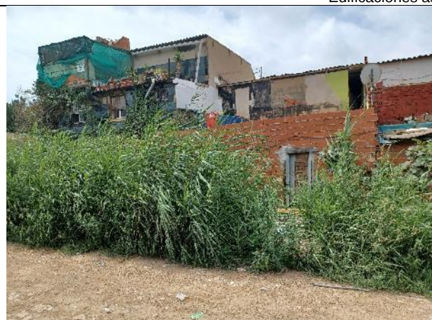
Figura 21: Edificaciones del lado norte en asentamiento Pedros 2.
