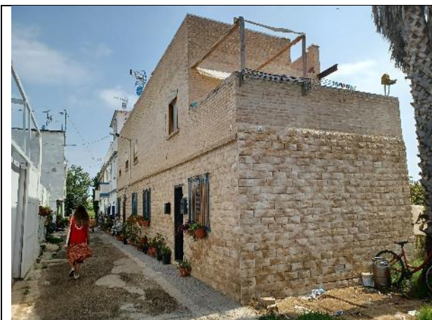
Figura 14: Edificaciones del lado este en asentamiento Pedros 1. Vista desde el sur
