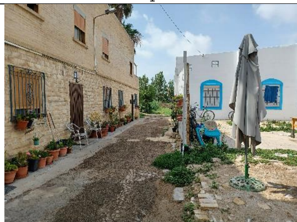
Figura 17: Edificaciones y urbanización asentamiento Pedros 1. Vista hacia el sur
