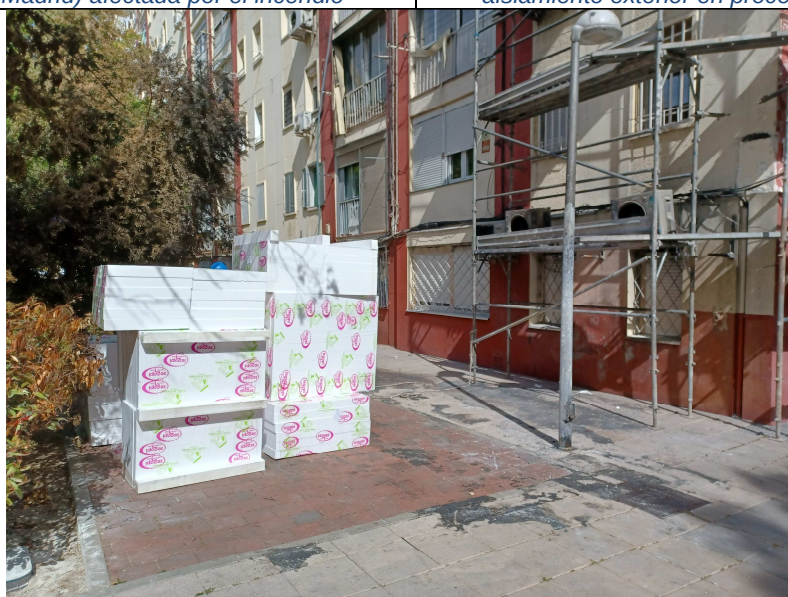
Ilustración 33: Acopio de paneles de aislamiento
