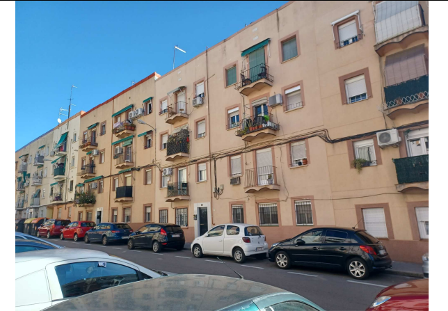
Ilustración 37: Diversas viviendas con sistemas de climatización
