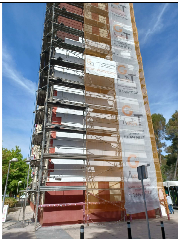
Ilustración 32: Fachada este del edificio con sistema de aislamiento exterior en proceso de colocación
