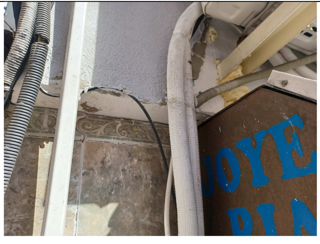
Ilustración 35: Edificio con sistema de aislamiento externo de poliestireno expandido
