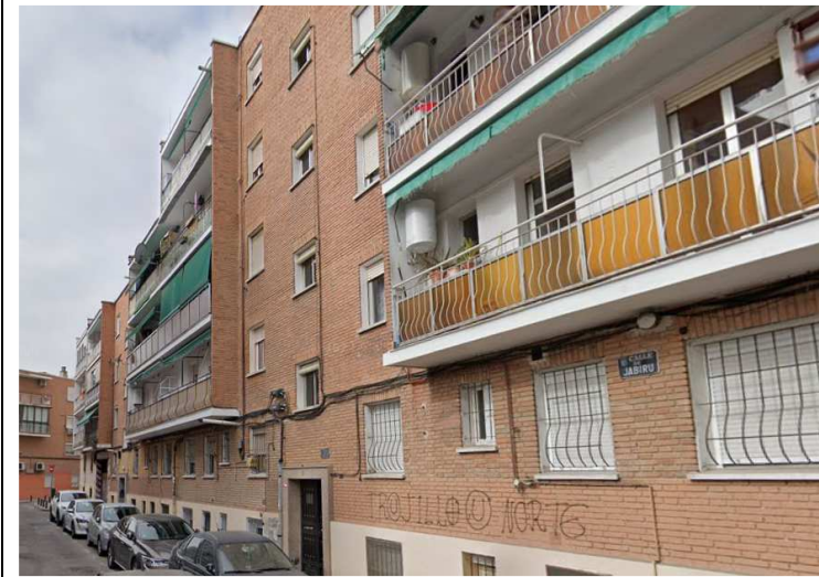
Ilustración 19: Edificio de viviendas C/Jabiru 2
