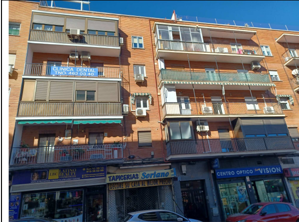
Ilustración 36: Diversas viviendas con sistemas de climatización
