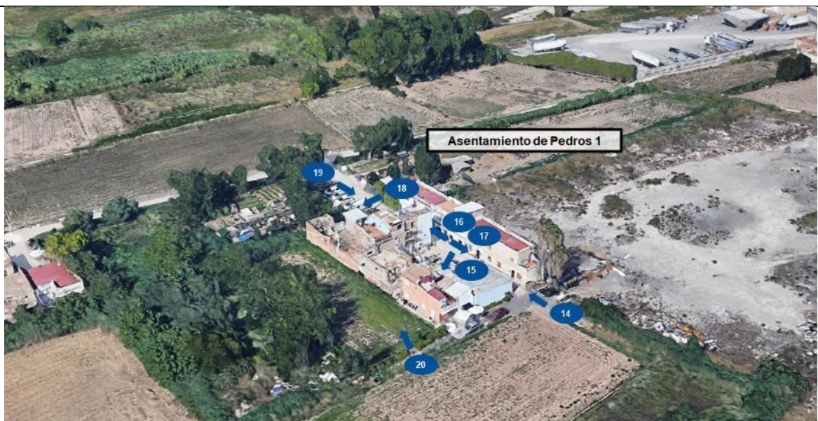
Edificaciones asentamiento Pedros 1
