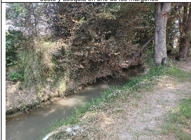
Figura 8: Acequia margen derecha del camino con sentido desde asentamientos
