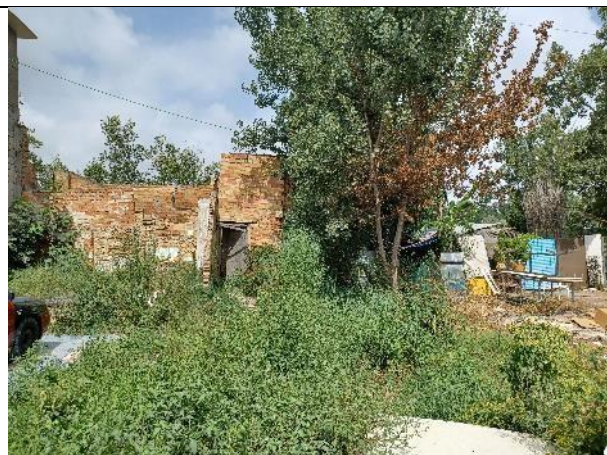
Figura 19: Edificaciones asentamiento Pedros 1. Vista desde el norte
