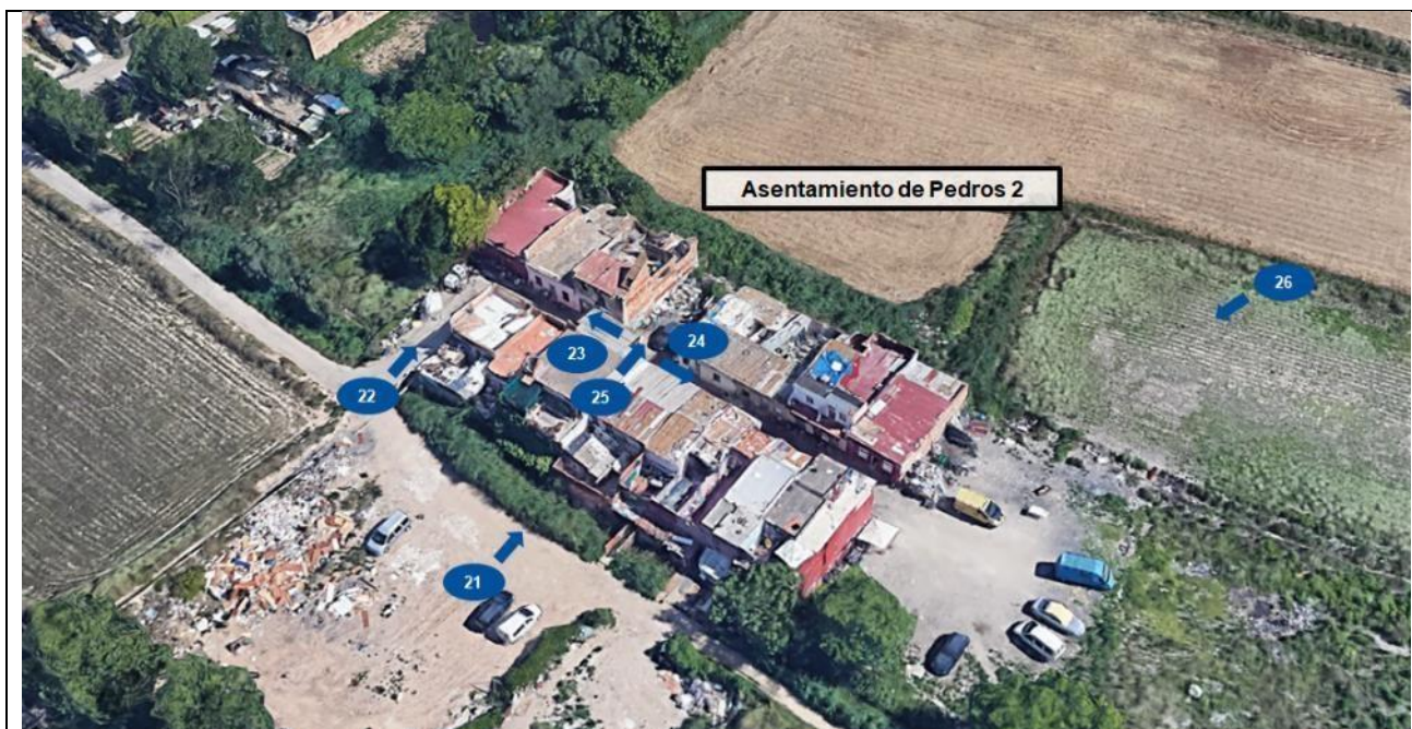
Edificaciones asentamiento Pedros 2
