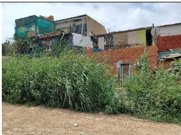
Figura 21: Edificaciones del lado norte en asentamiento Pedros 2.
