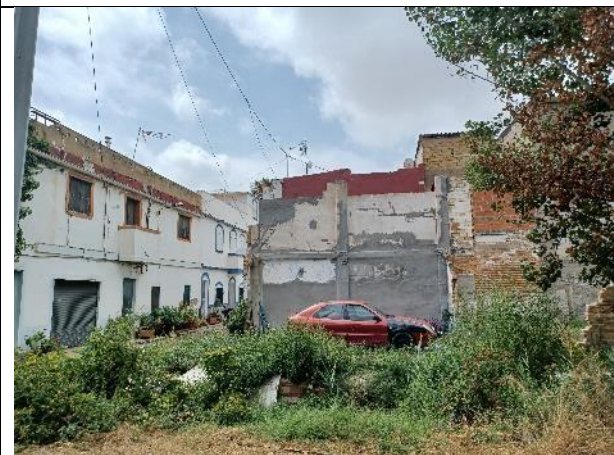
Figura 18: Edificaciones asentamiento Pedros 1. Vista desde el norte
